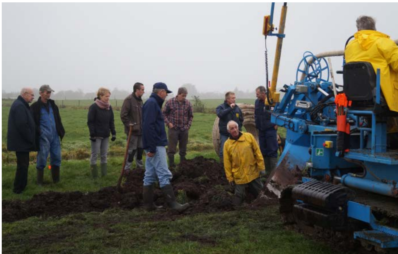
FOTO 2: AANLEG AANSLUITING OP VERBINDINGSRAIN.
